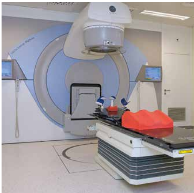
Dispositivo per la radioterapia (acceleratore lineare) con lettino e presidi d'immobilizzazione (in rosso).
